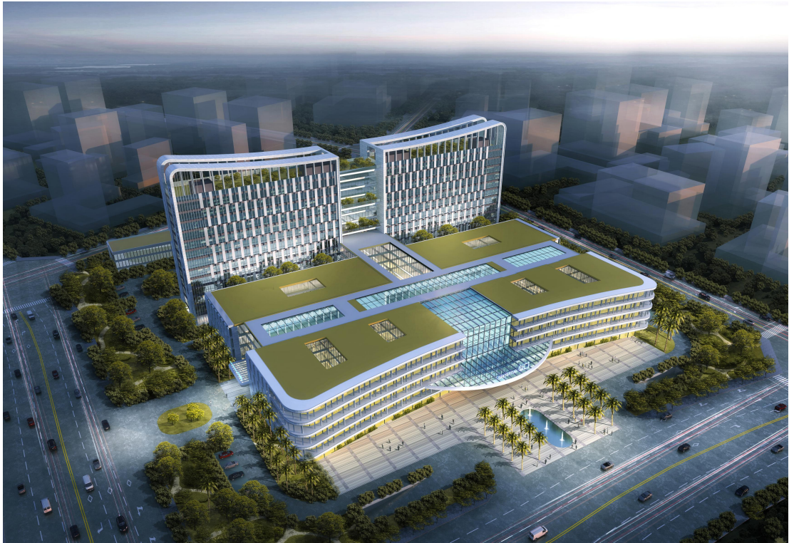
(在建中的新院区)
